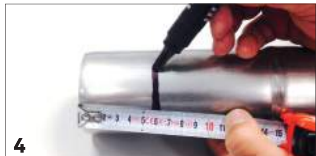
4 Marcatura quota d'innesto / Marking the insertion's depth
